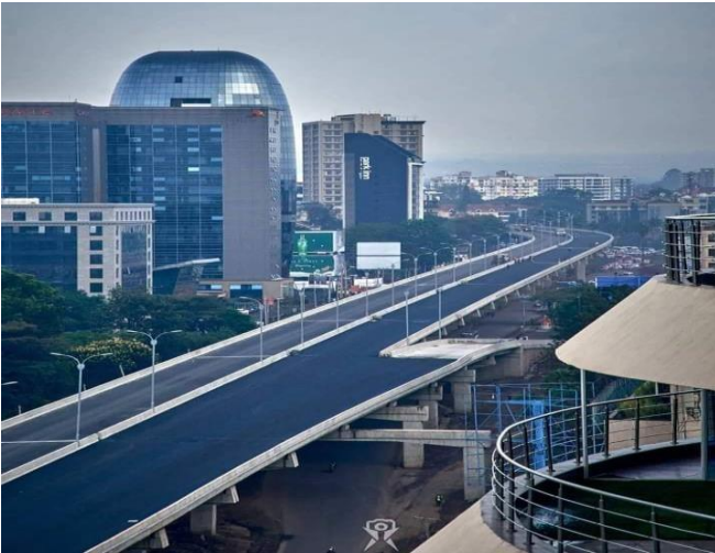
Ujenzi ukiendelea katika barabara ya Ruaraka - Outer Ring
